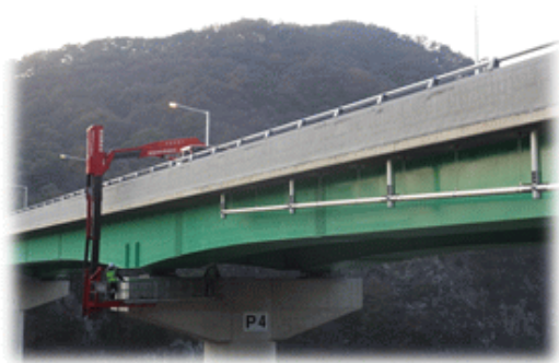
교량 초기점검 현황 (굴절차 점검)
