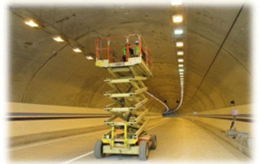
터널 초기점검 (고소차 점검)
