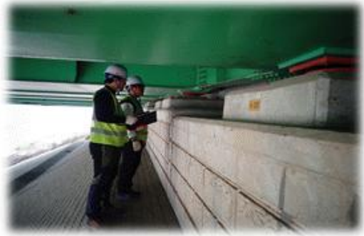
교량 정밀점검 현황 (외관조사)
