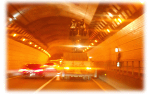
터널 정밀점검 현황 (외관조사)
