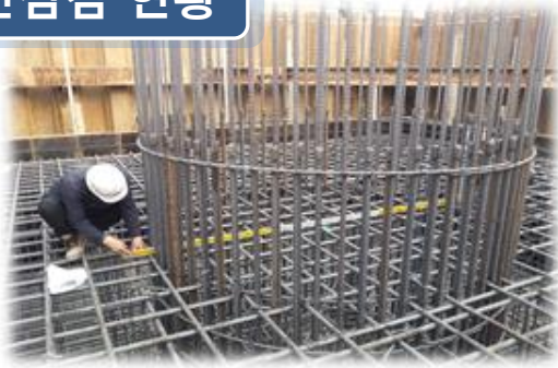
교량 공사중점검 현황 (제원조사)
